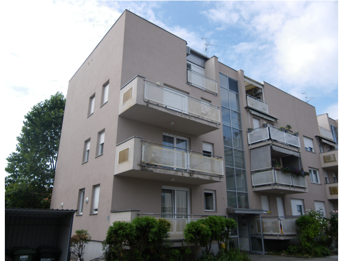
Foto 2: Pogled na stambenu zgradu Karlovačka cesta 6C (10.07.21. 10.00 h)
