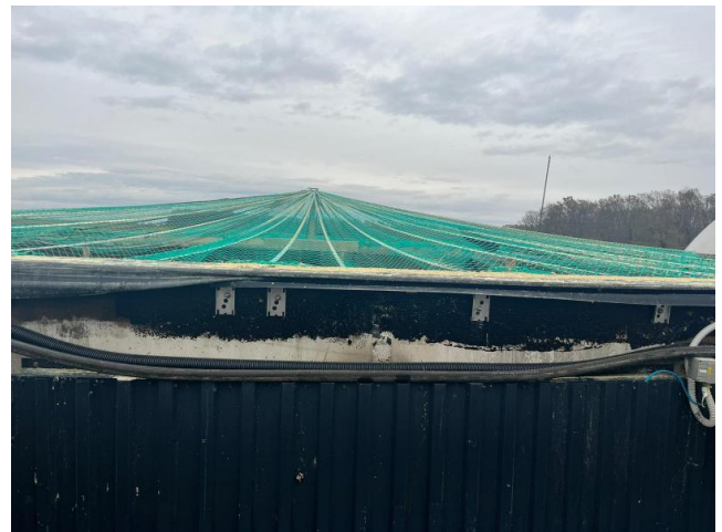
Fotografija 7. i 8. Otkinute membrane na fermetnoru 2
