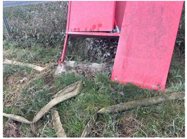
Fotografija 3 i 4. Oštećenje ormarića vanjskog hidranta
