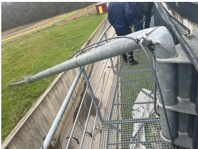
Fotografija 1 i 2. – savijanje stupa gromobrana na fermentoru 2
