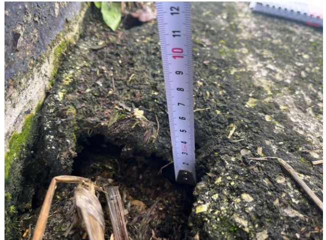
Fotografija 16. Diferencijalno slijeganje tla na pisti sjeverne lagune (debljina asfaltnog sloja oko 2,0 cm)
