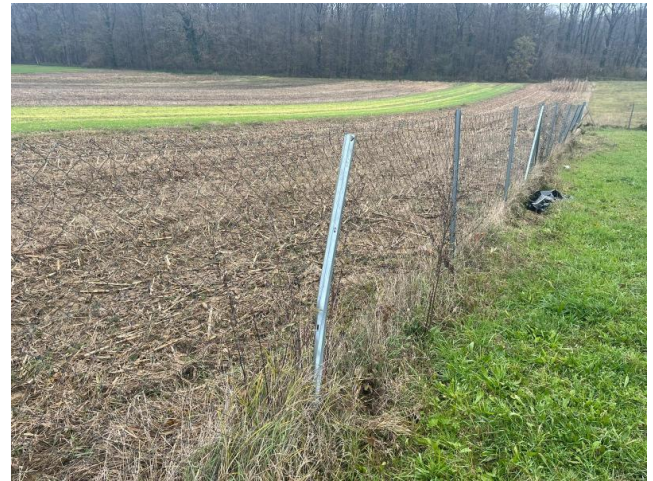
Fotografija 5. i 6. Oštećenje žičane ograde i metalnih stupova na istočnom dijelu parcele (oštećeno 6 polja)
