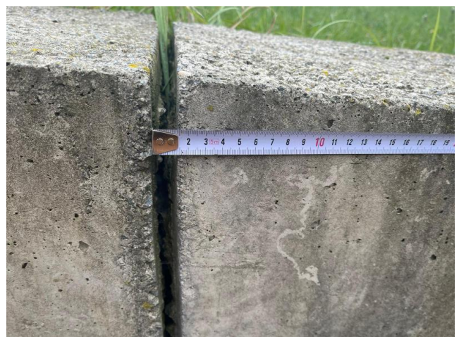
Fotografija 14. Odvajanje dijela potpornog zida
