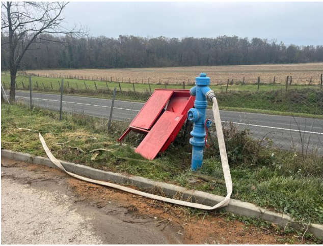
Fotografija 3 i 4. Oštećenje ormarića vanjskog hidranta
