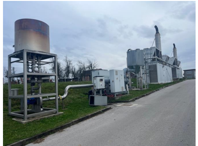
Fotografija 24. Baklja i dva plinska motora s generatorima smješteni u kontejnere
