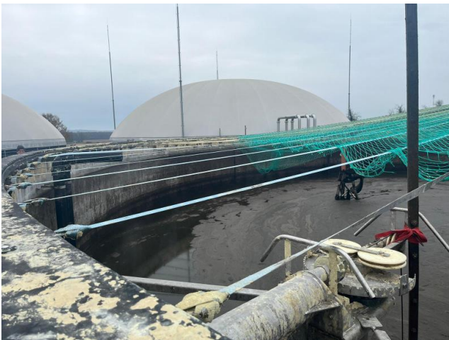
Fotografija 7. i 8. Otkinute membrane na fermetnoru 2
