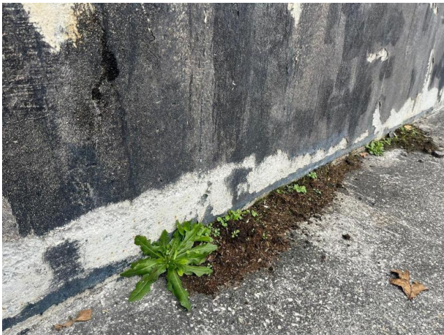
Fotografija 17. Rast samoniklog bilja, te oštećenje završnog sloja zida sjeverne lagune
