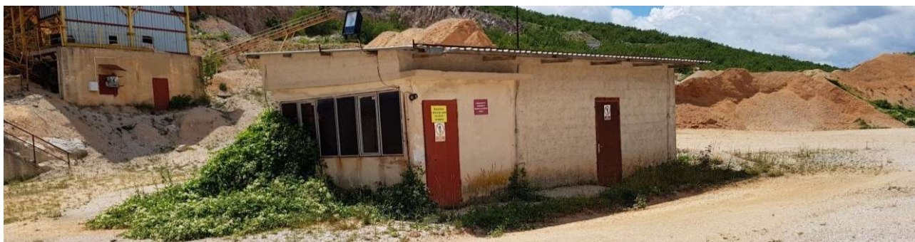
Slika 4-18 – Upravljačka kućica postrojenja za oplemenjivanje mineralne sirovine
