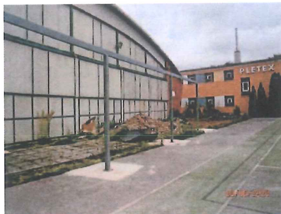
Nadstrešnica na istočnom pročelju
