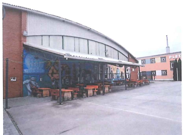
Nadstrešnica na istočnom pročelju
