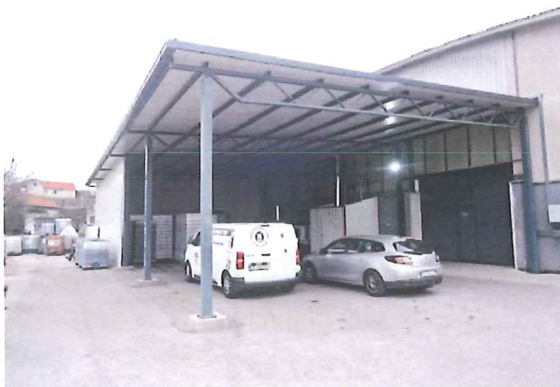
Nadstrešnica na zapadnom pročelju
