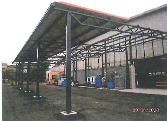
Nadstrešnica na zapadnom pročelju
