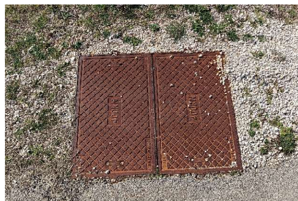
Fotografija 6 – Okno uz novo asfaltirani dio ulice
