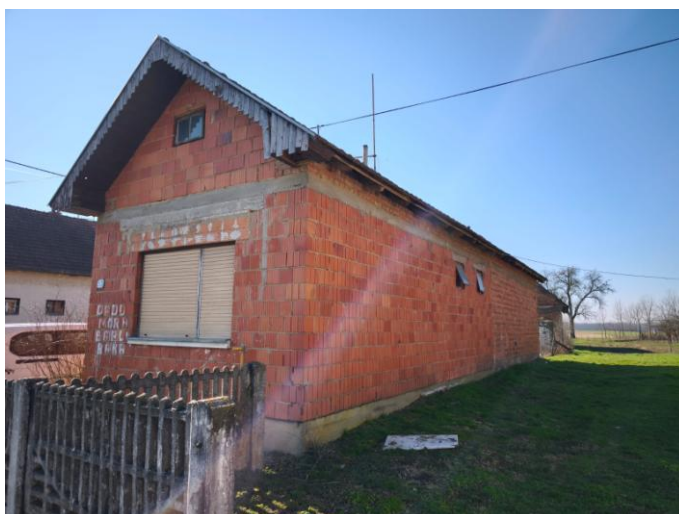
Slika 3: Stambena zgrada s pomoćnim dijelom na k.č.br. 251, k.o. Lozan
