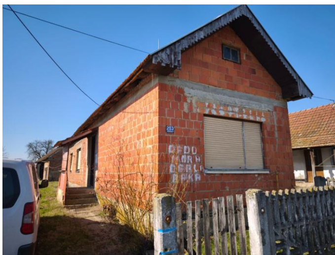
Slika 1: Stambena zgrada s pomoćnim dijelom na k.č.br. 251, k.o. Lozan
