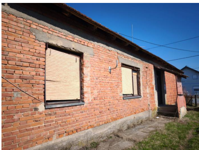
Slika 2: Stambena zgrada s pomoćnim dijelom na k.č.br. 251, k.o. Lozan
