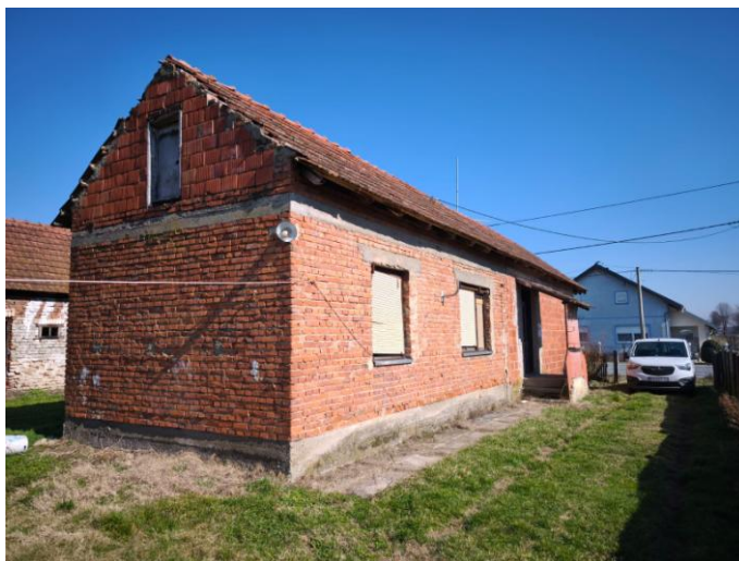
Slika 4: Stambena zgrada s pomoćnim dijelom na k.č.br. 251, k.o. Lozan
