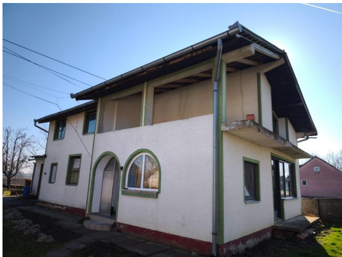
Slika 5: Stambena zgrada 2 na k.č.br. 825/137 (1208/114), k.o. Stari Gradac
