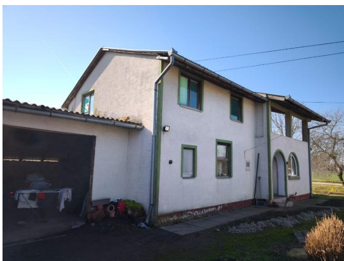
Slika 6: Stambena zgrada 2 na k.č.br. 825/137 (1208/114), k.o. Stari Gradac
