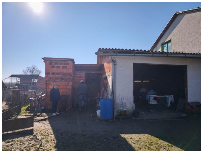
Slika 7: Stambena zgrada 2 na k.č.br. 825/137 (1208/114), k.o. Stari Gradac
