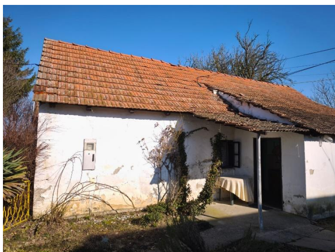
Slika 2: Stambena zgrada 1 na k.č.br. 825/136 (1208/113), k.o. Stari Gradac
