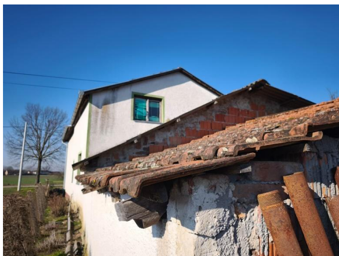
Slika 8: Stambena zgrada 2 na k.č.br. 825/137 (1208/114), k.o. Stari Gradac
