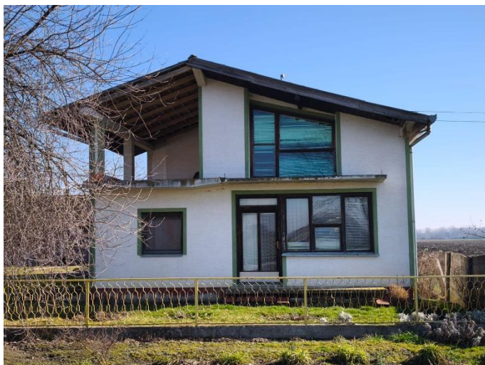
Slika 4: Stambena zgrada 2 na k.č.br. 825/137 (1208/114), k.o. Stari Gradac
