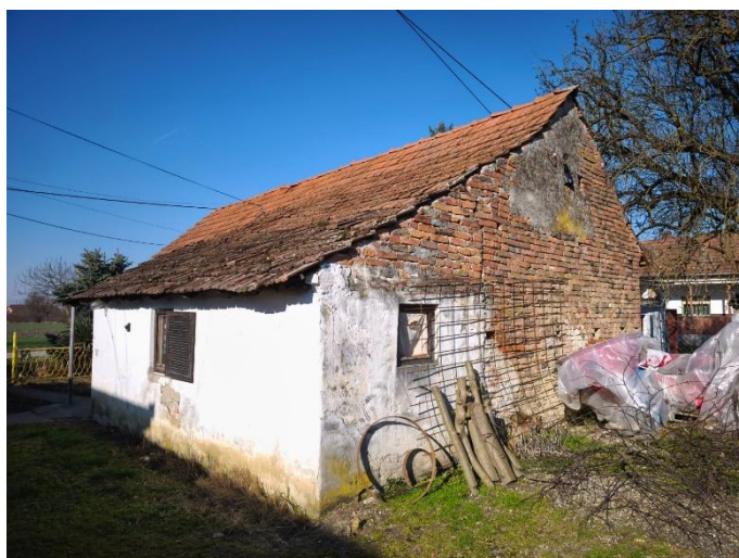
Slika 3: Stambena zgrada 1 na k.č.br. 825/136 (1208/113), k.o. Stari Gradac
