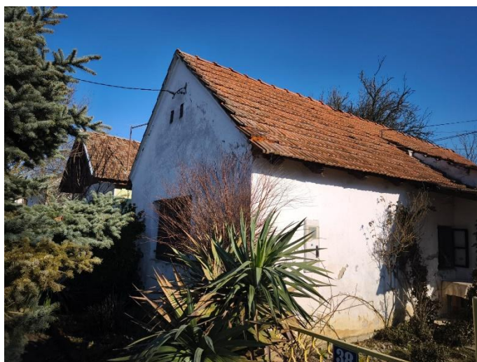
Slika 1: Stambena zgrada 1 na k.č.br. 825/136 (1208/113), k.o. Stari Gradac
