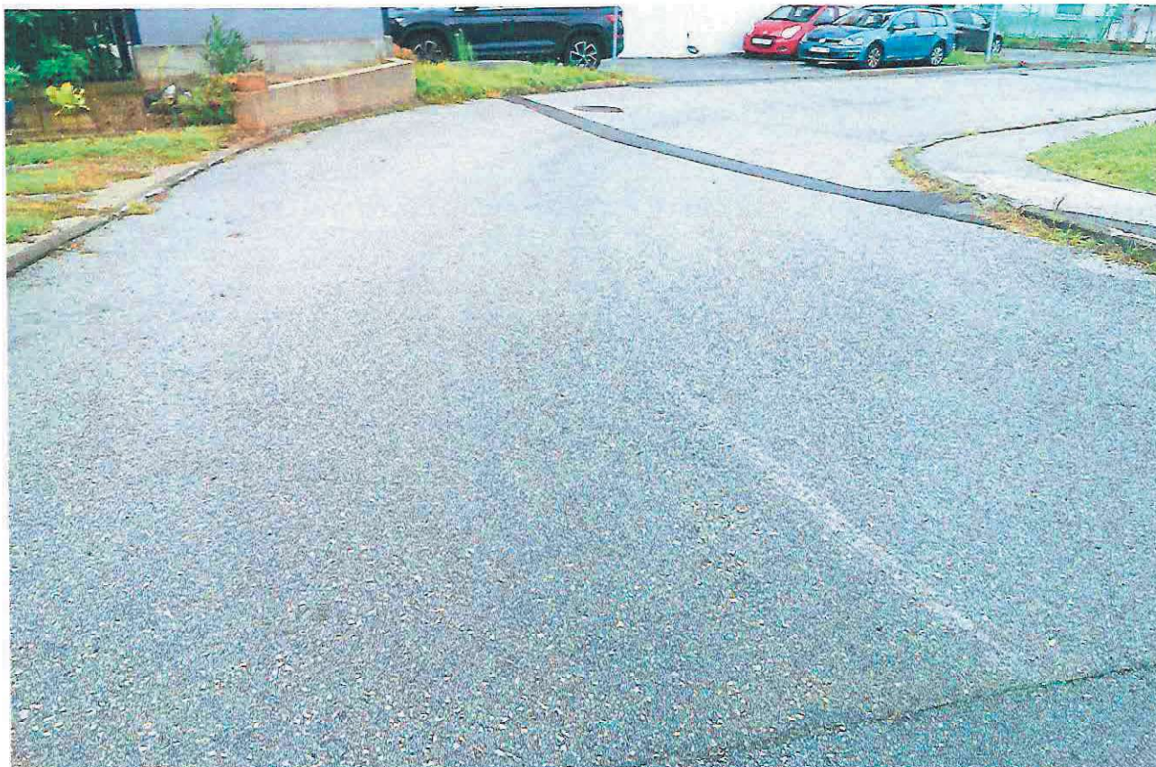
Slika 1 Pogled s nerazvrstane ceste na dio k. č. br. 3538/3. U pozadini vidljiv parking kuće na broju 1. Širina asfaltnog kolnika oko 5,50 m do 5,75 m.
