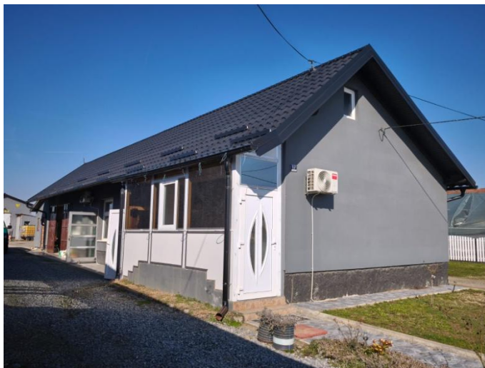
Slika 1: Stambena zgrada s pomoćnim dijelom na k.č.br. 419/3, k.o. Lozan
