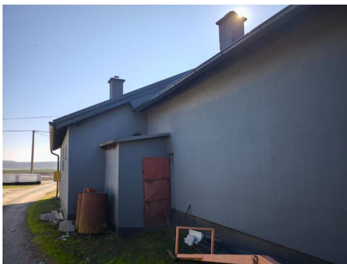
Slika 3: Stambena zgrada s pomoćnim dijelom na k.č.br. 419/3, k.o. Lozan
