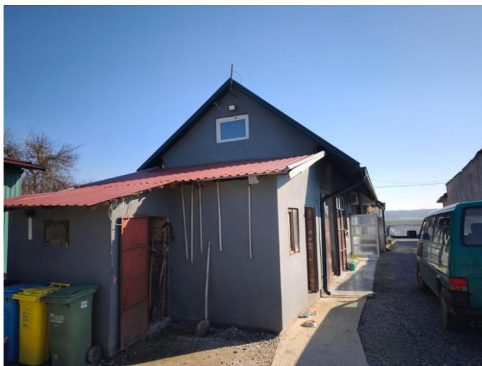
Slika 4: Stambena zgrada s pomoćnim dijelom na k.č.br. 419/3, k.o. Lozan
