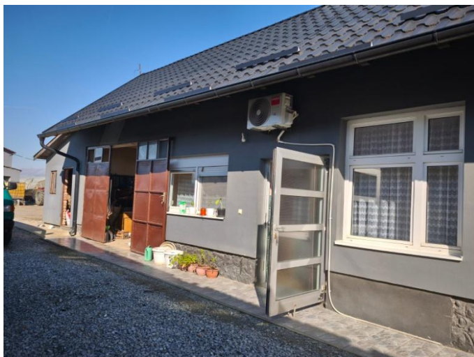
Slika 2: Stambena zgrada s pomoćnim dijelom na k.č.br. 419/3, k.o. Lozan
