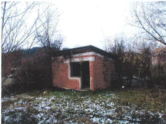
Slika 3: Zgrada 1-pokraj cisterne
