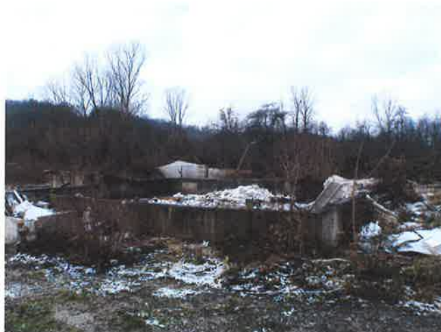
Slika 5: k.č.br.6569-ostatci asfaltne baze
