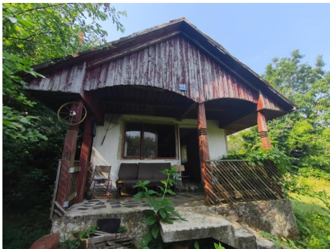
Slika 1: Pomoćna zgrada – klijet na k.č.br. 919/6, k.o. Vukosavljevica
