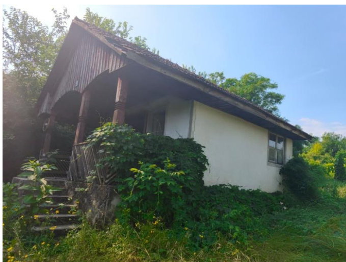
Slika 2: Pomoćna zgrada – klijet na k.č.br. 919/6, k.o. Vukosavljevica
