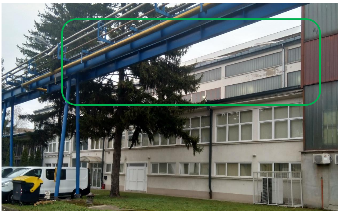
Fotografija 4 Kovačnica, zapadno strana, dijelom zaklonjena
