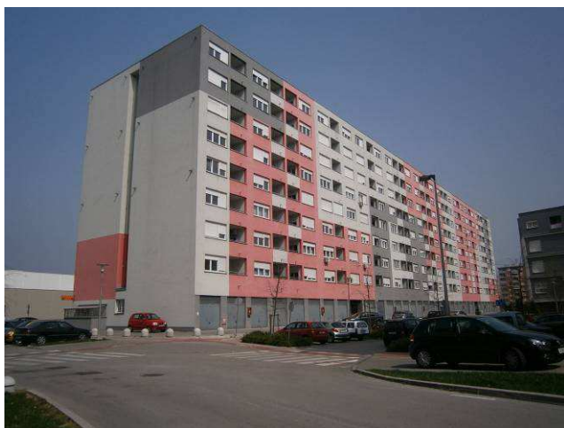
Foto 1: Zgrada u kojoj se nalazi garaža G-98 (lipanj 2014.)
