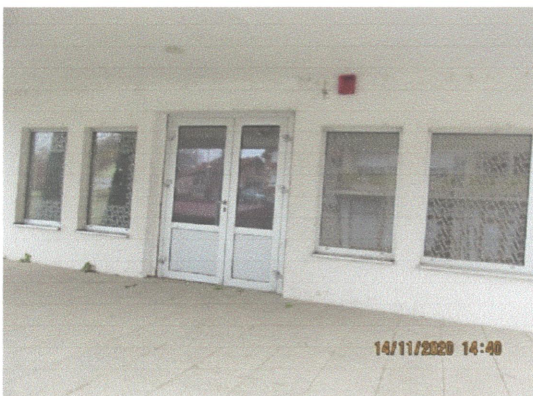
ulaz sa ulice
