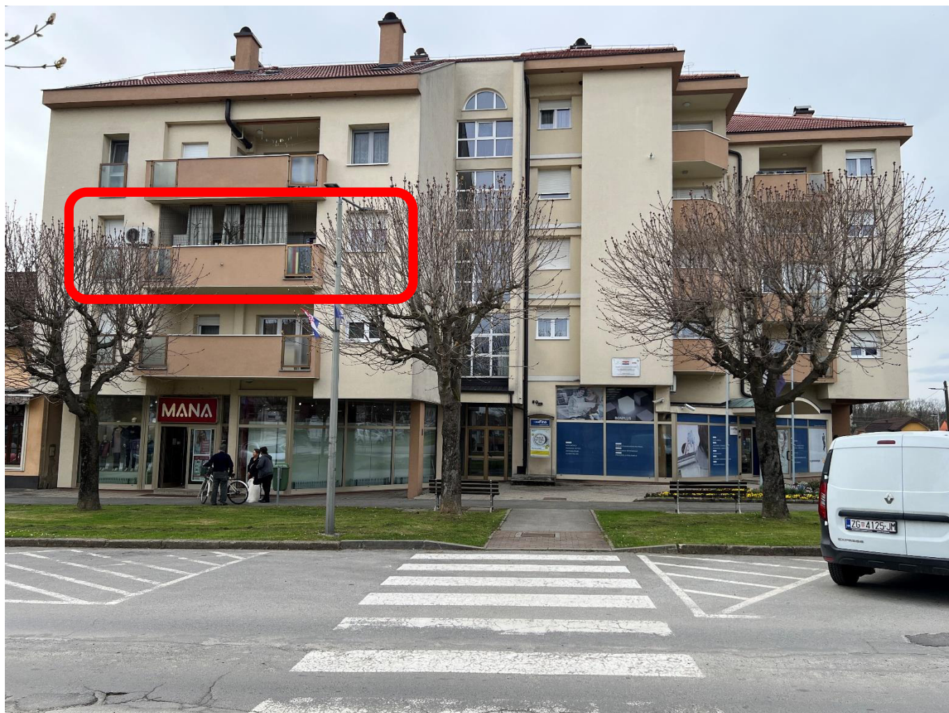
Pogled na zgradu
